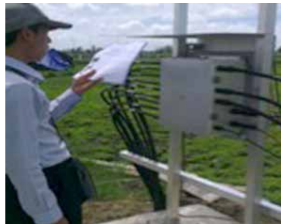
Gambar Pemeriksaan penangkal petir dan switch antenna L-HF di Merauke
